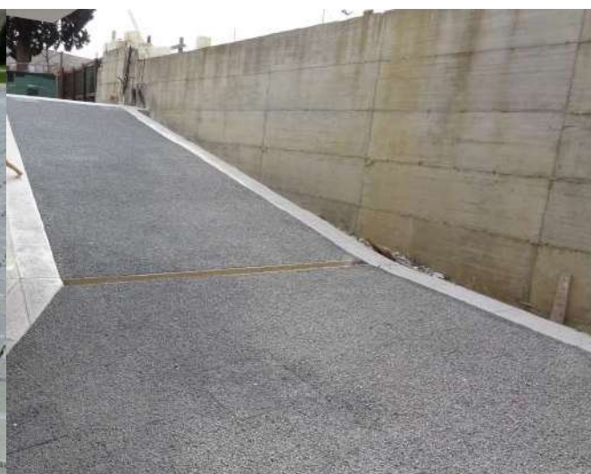
Pavimentazione in calcestruzzo drenante
