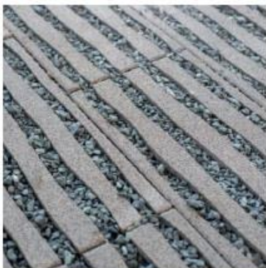
Pavimento in masselli drenanti Pavimentazione drenante
